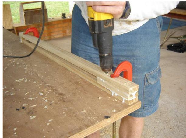
Para fixar o pé superior no secador, faça um furo no meio da parede superior da caixa, a 6 cm do fundo, entre as duas janelas de ventilação.
