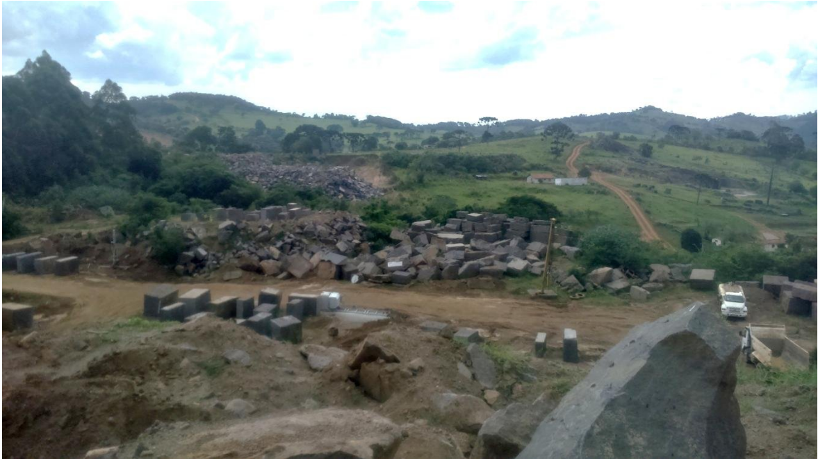
Foto 5: Pilha de rejeito e blocos localizados na porção inferior do empreendimento (a pilha localizada ao fundo da imagem pertence à mineradora GRANITA). Data: 21/01/2015.
