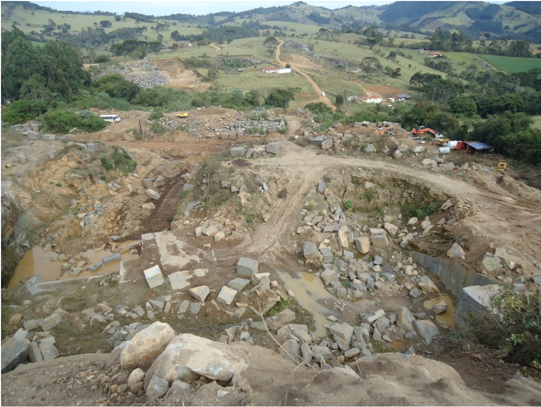
Foto 1: Vista geral do empreendimento, a partir do ponto mais elevado em 20/06/2013 .
