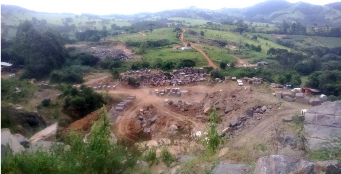
Foto 2: Vista geral do empreendimento, a partir do ponto mais elevado em 21/01/2015 .
