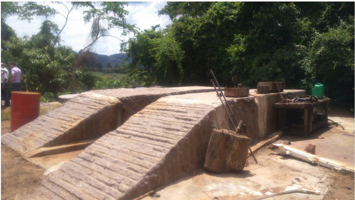
Foto 8: Vista geral da rampa de troca de óleo. Data: 21/01/2015.
