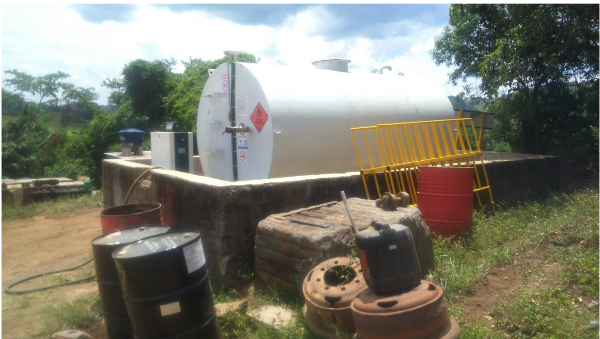
Foto 10: Vista geral do tanque de combustíveis. Data: 21/01/2015.
